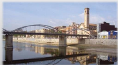
CAPTACIÓ RIU EBRE
