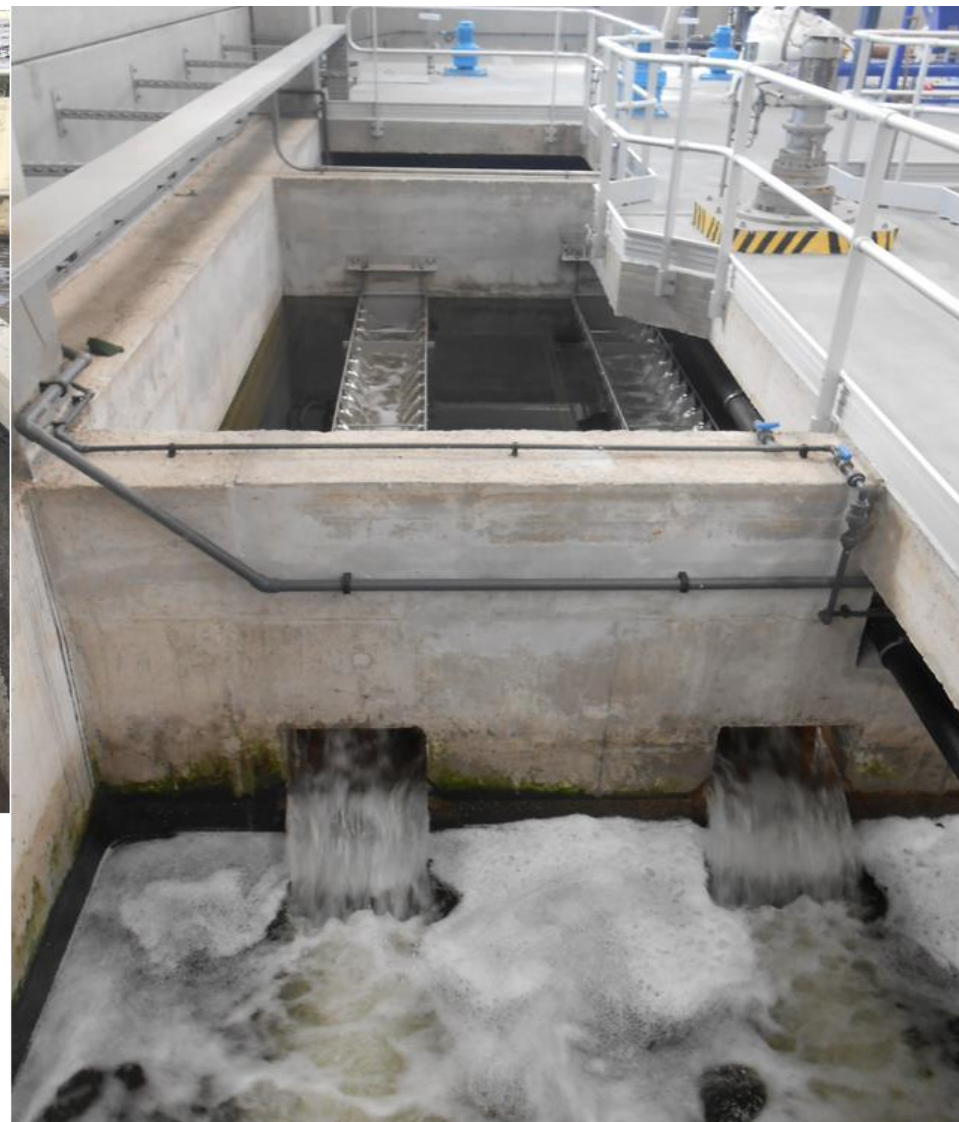
FILTRACIÓ PER DECANTACIÓ (ACTIFLO®)
