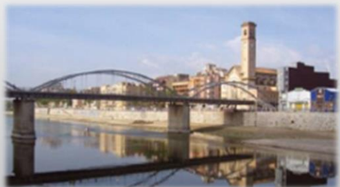
CAPTACIÓ RIU EBRE
