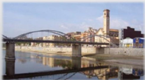
CAPTACIÓ RIU EBRE
